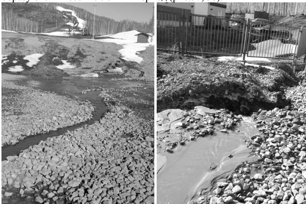
Рис.57, 58. Система ливневой канализации в первые годы не справлялась с потоком талых вод с оголенных склонов (фото апрель 2005 года).
