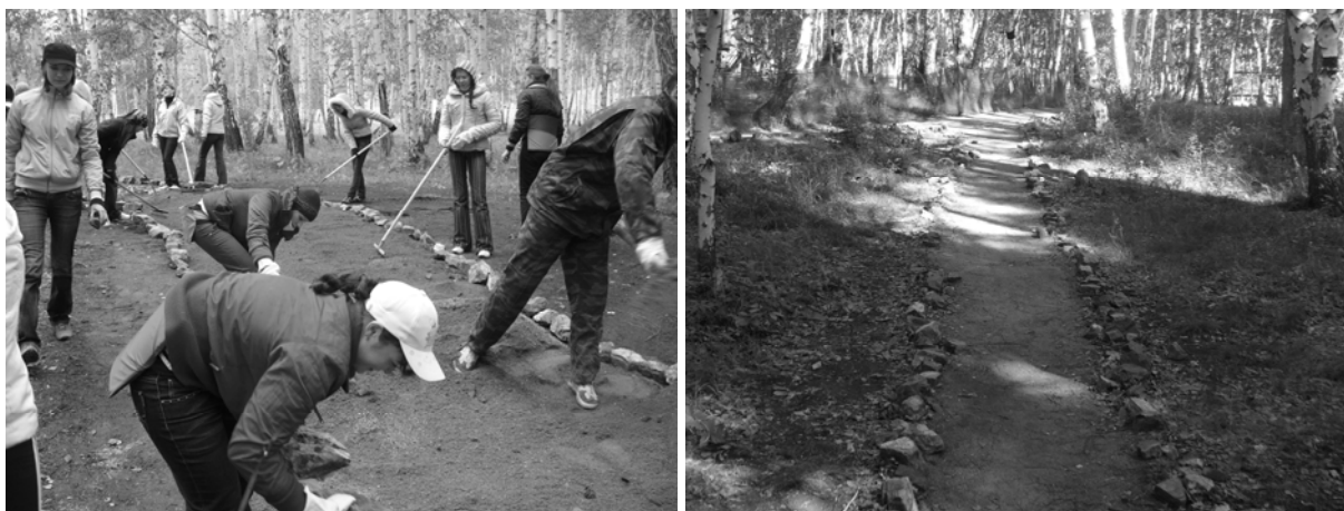
Рис.51,52. Отсыпка троп песчано-гравийной смесью.
