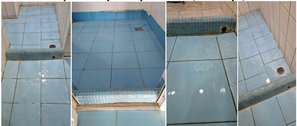
Рис. 56. Капитальный ремонт ножных ванн душевых СК "Сокол" и бассейна "Буревестник"
