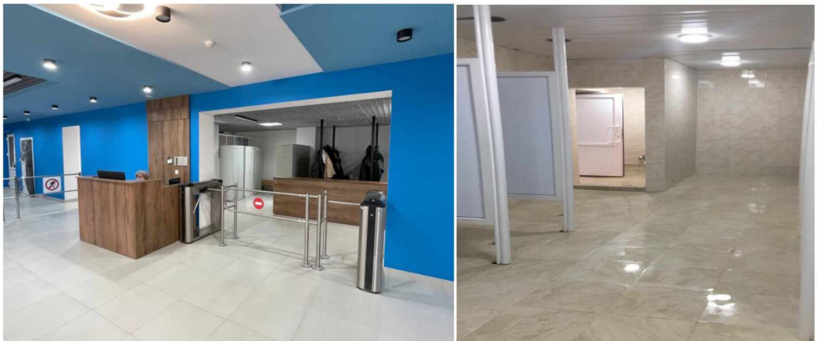
Рис. 71. Текущий ремонт фойе и мужской душевой учебного корпуса №8
