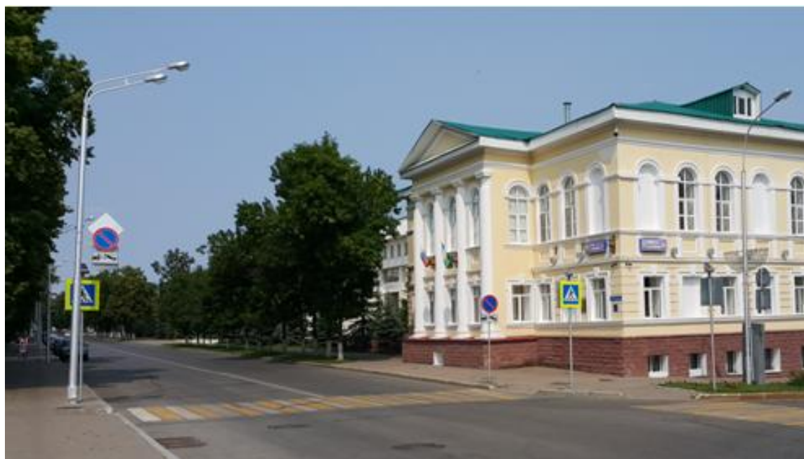
Так выглядит южная часть Советской (Губернаторской) улицы. Старые дома уже снесены. На заднем плане виднеется здание Курултая.
