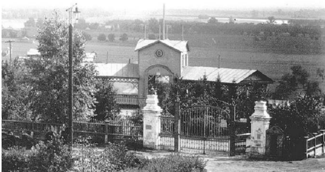
Вид читального павильона со стороны входа.
