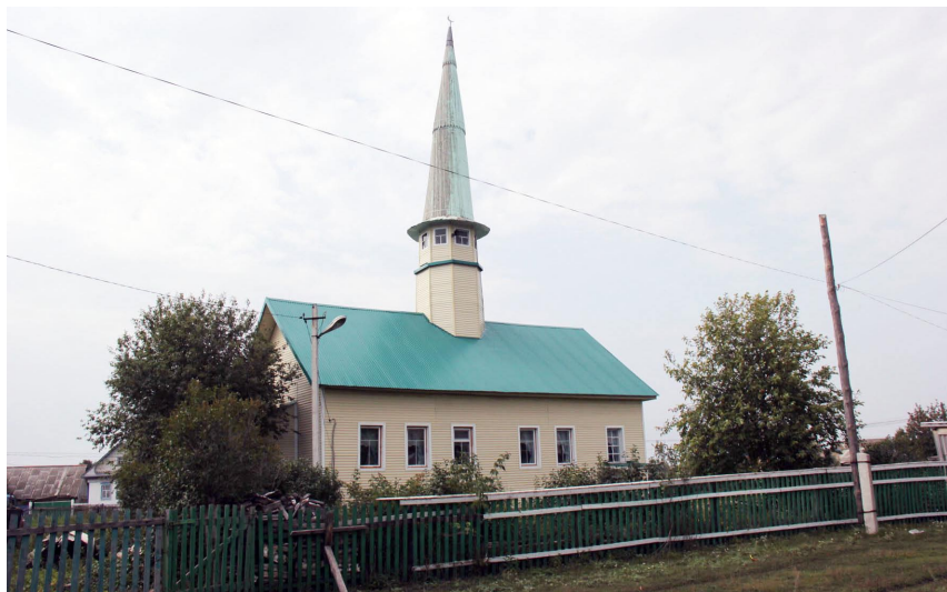
Фото 23. Старейшая деревянная мечеть Башкирии, построена в 1738 г. Балтачевский район, с. Староякшеево, 2013 г. Фото автора
