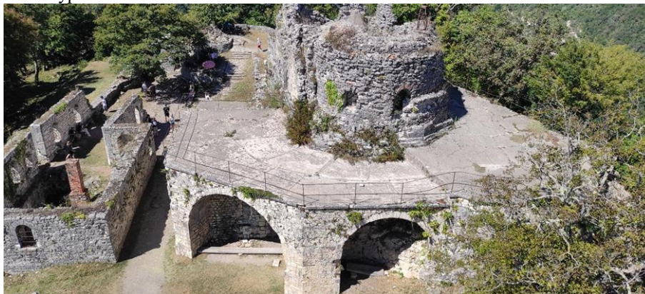
Илл.1. Вид на Храм Св. Феодора Тирона со стороны Восточной дозорной башни. На фото видна четко выраженная апсида с несколькими окнами
