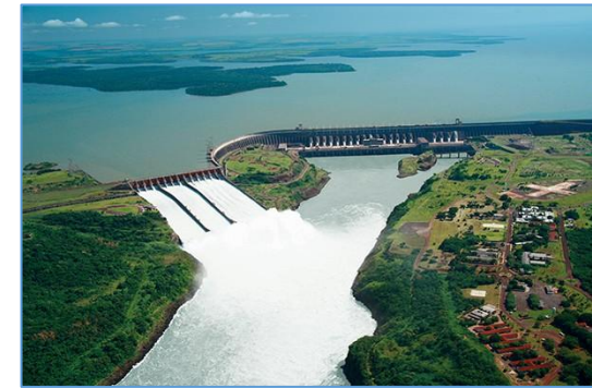
ГЭС Итайпу Бразилия / Парагвай 14000 МВт (1984 г.)
